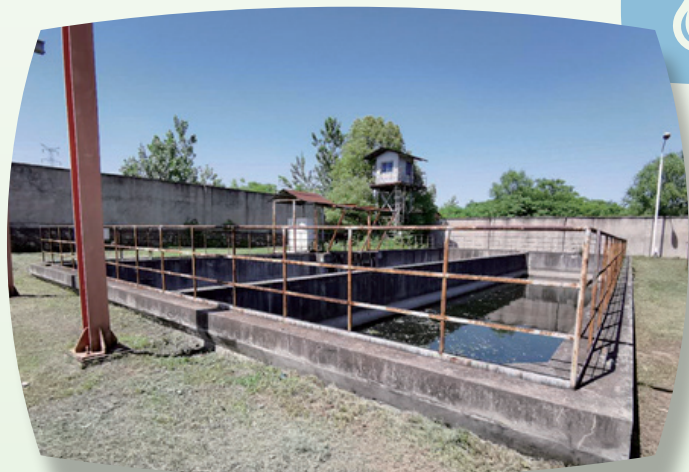
Sewage treatment facilities at LPG storage tank farm of Minsheng Gas 位於民生石油的液化石油氣儲庫基地之污水處理設施
